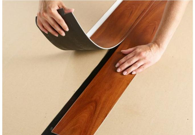
ne vous détrompez pas; le plancher de vinyle réagit lui aussi aux variations de température et d'humidité, comme le bois franc. Il est donc tout aussi important de suivre les recommandations du fabricant du vinyle. Ce type de plancher peut s'installer de façon collée ou flottante avec un système d'installation « à clic ».
