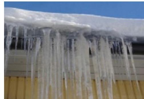
Lors de redoux, la glace empêche l'eau de bien s'écouler vers le bas, la forçant à remonter et à s'infiltrer par les joints et tous les endroits non scellés. Imperméabiliser la toiture ne réglera pas le problème de formation de glace, mais empêchera l'eau de s'infiltrer.
